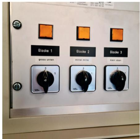
**Gab es auch schon Pannen?** Wenn der Motor startet, höre ich, ob die Glocke in Schwingung gerät. Einmal hat die kleinste nicht funktioniert, die Software musste dann erneuert werden. Jährlich lade ich den Kirchturmtechniker ein, damit er den Service leistet. Er überprüft und wartet den Antrieb, die Glockenschwunghöhe (Sicherheits-Höhenbegrenzung), Lagerung und Aufhängung. Die offene Bauweise bedeutet einen Mehraufwand. Ohne Hebebühne geht es nicht. Die Sicherheit muss
