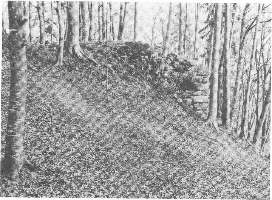
Bild 2: Teile der Ruine Blankenburg
