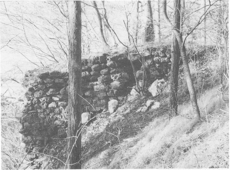
Bild 1: Teil der Ruine Hohburg
