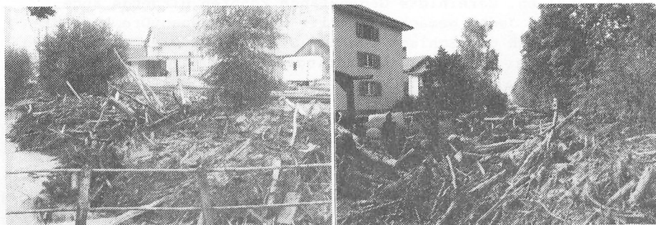
Chaotische Bilder vom Montagmorgen, 30. Juli 1990. Links ein Haufen Schwemmholz, rechts die Gürbestrasse mit dem schon am 8. Juni 1990 überschwemmten Haus
