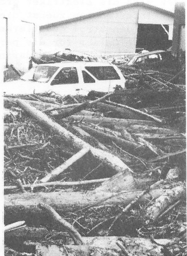
Hinter den demolierten Autos die zerstörte Lagerhalle der Elementküchen AG
