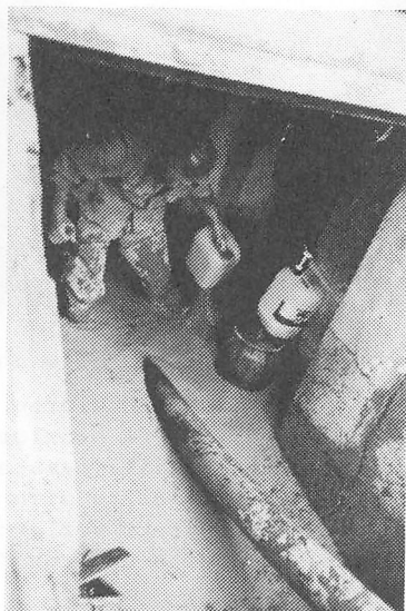
Ein Keller wird ausgepumpt
