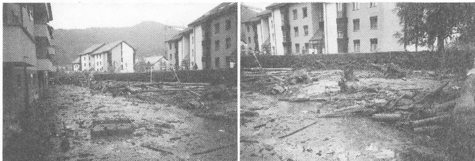
Schlamm, Holz, Hausrat südlich des Mehrfamilienhauses Gürbestr.19 Im Hintergrund die ebenfalls überschwemmte Überbauung "Gürbe"
